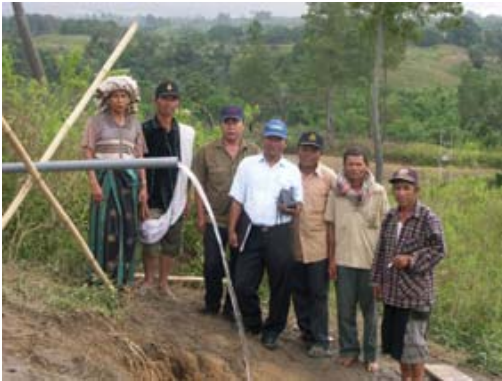
Im Oktober sollen alle Häuser des Dorfes dann an die Wasserversorgung angeschlossen werden
